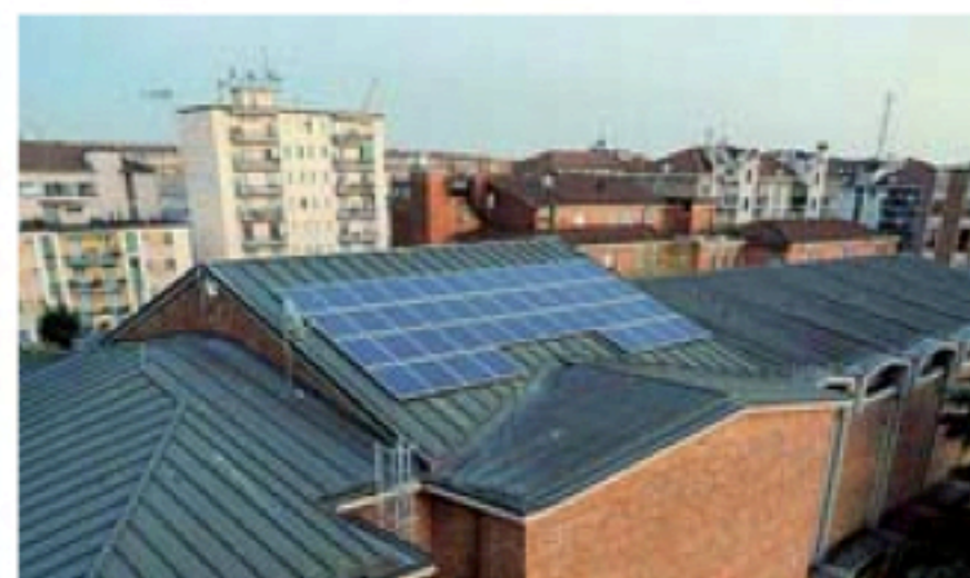
Via Carnia I pannelli fotovoltaici sulla chiesa parrocchiale
